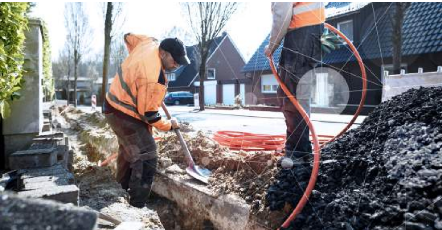
Eine Glasfaserbaustelle im Münsterland; Der Ausbau leistungsfähiger Gigabitnetze mit schnellen Datenverbindungen soll zügig vorangehen.
